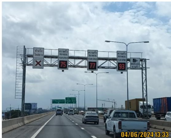
รูปที่ 3.1-5 ป้ายแสดงความเร็วของรถ (Your speed sign)
