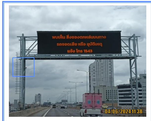
รูปที่ 3.2-2 กล้องโทรทัศน์วงจรปิด ตรวจจับรถวิ่งไหล่ทางพิเศษบูรพาวิถี
